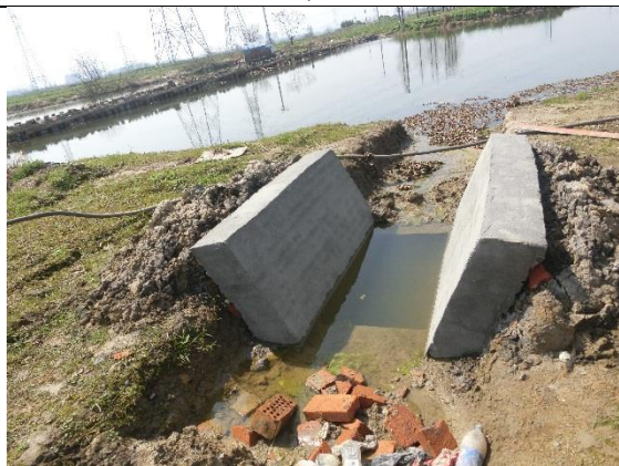
图 1-11 路基工程沉沙池法监测
