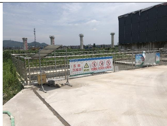
图 1-16 施工场地沉沙池法监测
