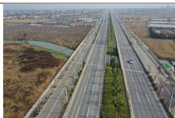
图 1-21 榆林中桥便道拆除后现状
