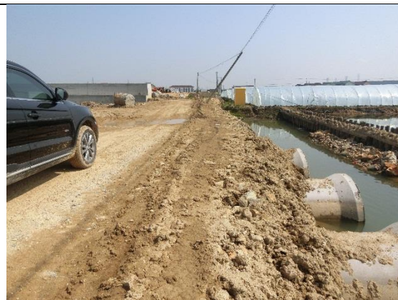
图 1-12 对施工便道进行调查监测
