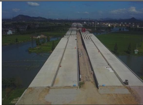
图 1-2 姜家江大桥无人机航测
