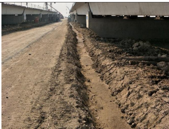
图 1-6 临时排水沟实地量测
