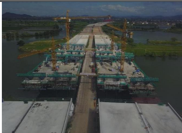
图 1-1 五港大桥施工无人机航测
