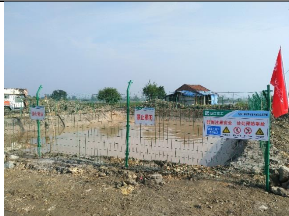
图 1-8 钻渣泥浆沉淀池法监测
