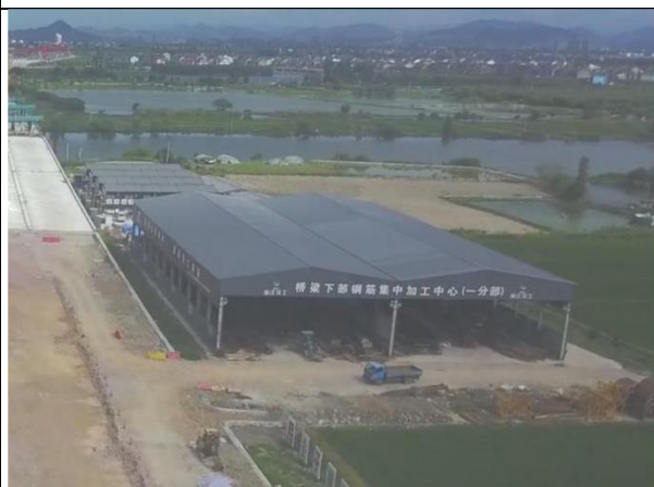
图 1-5 施工场地新增临时占地调查监测
