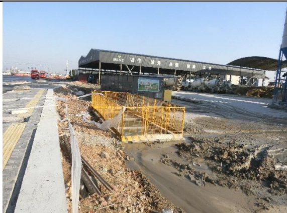
图 1-7 施工场地临时沉沙池法监测
